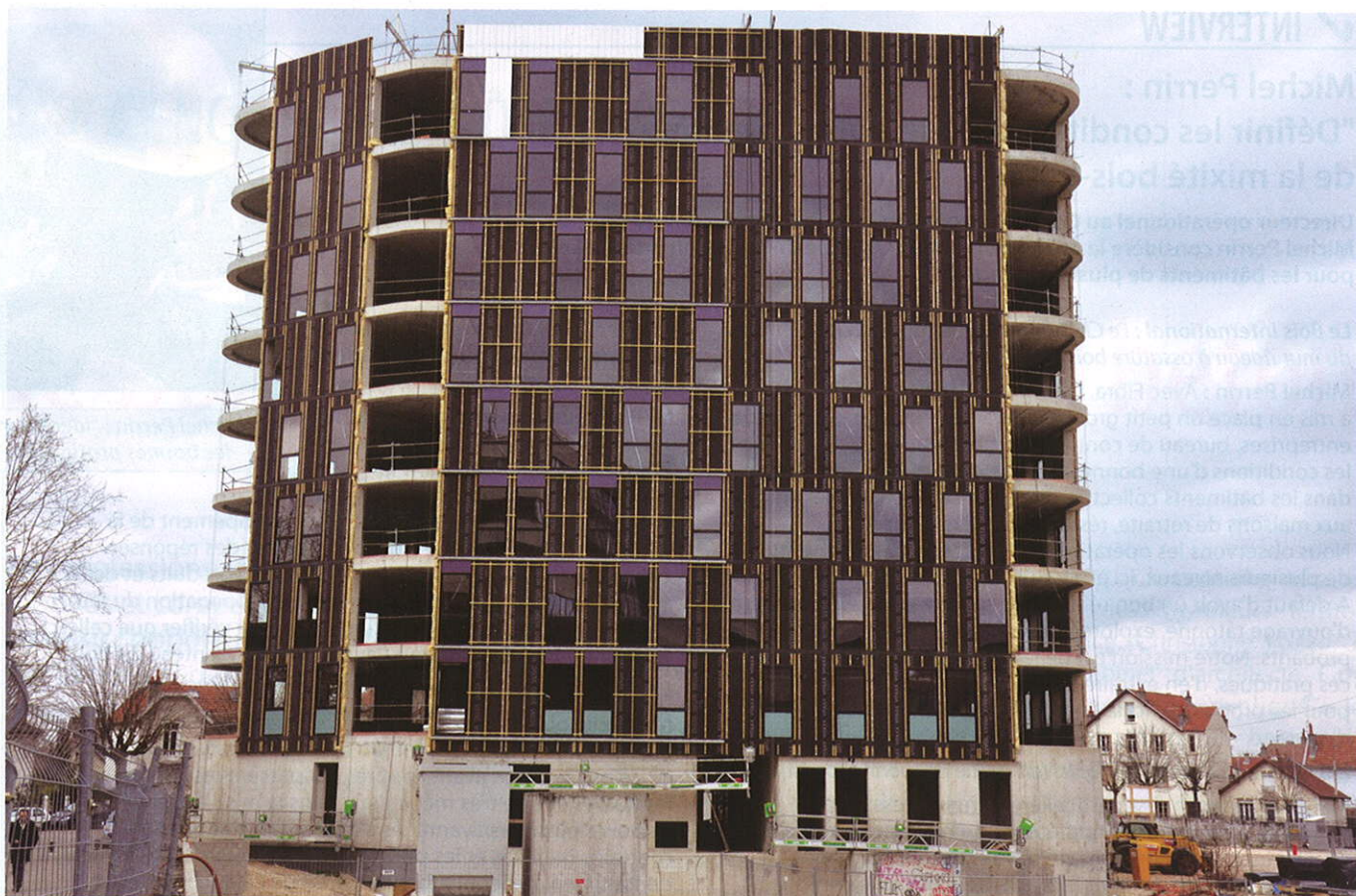
Les 383 panneaux d'ossature ont été posés en huit semaines.
