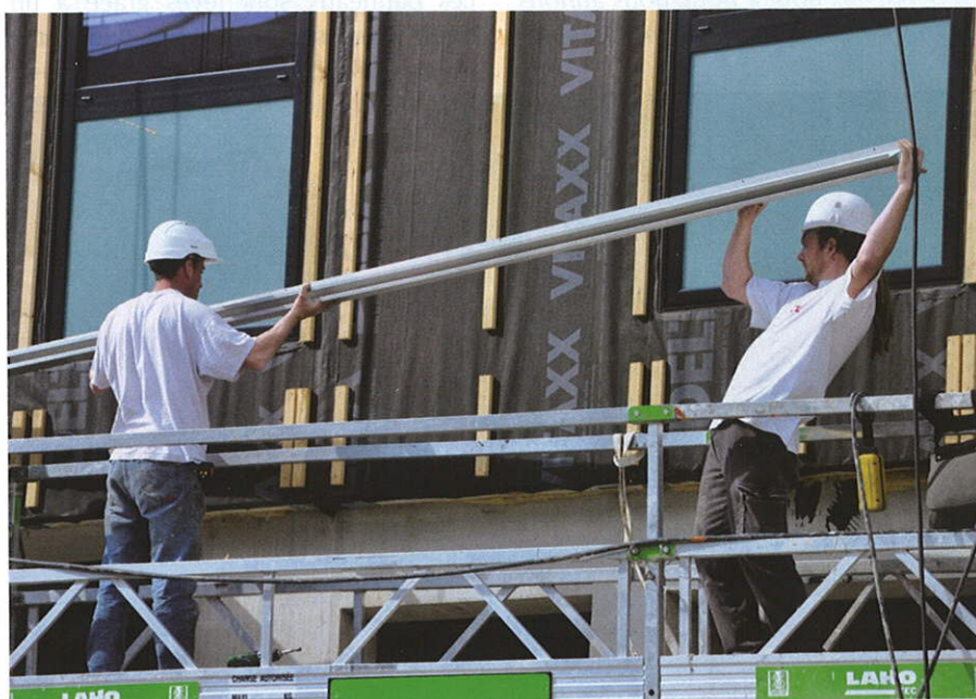
Les poseurs ont travaillé depuis des nacelles.
