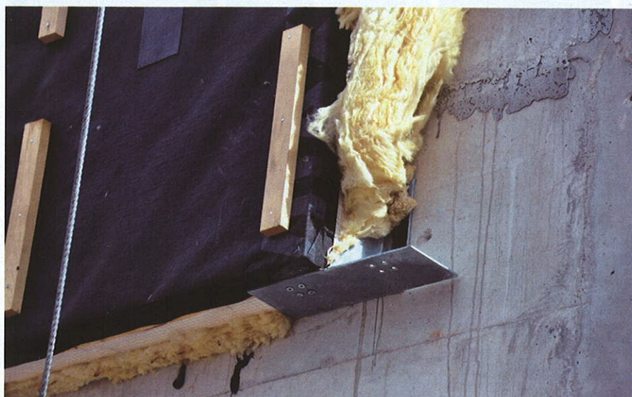
Les panneaux reposent sur des équerres fixées au croisement des poteaux et des dalles.
